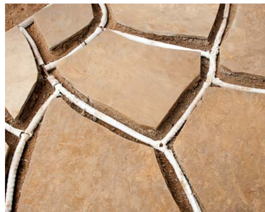
Inštalácia potrubí Eco-Wrap
