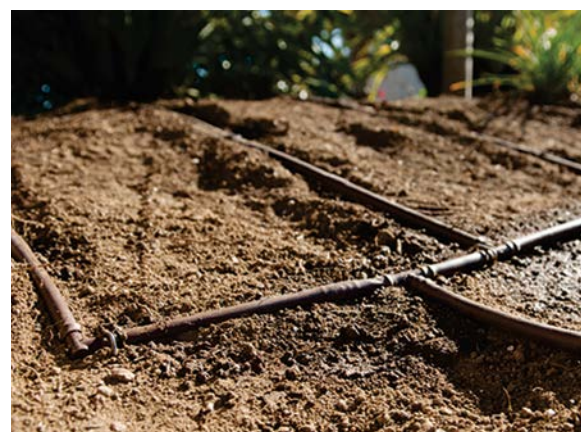
Nainštalované Potrubie PLD
